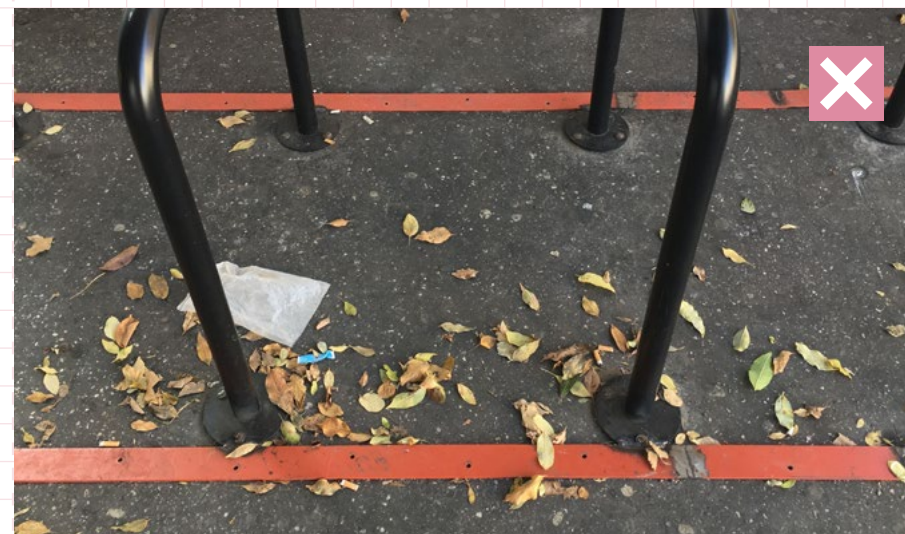
24 Nevhodné povrchové kotvenie cyklostojanov skrutkovaním oceľových páteiek do asfaltu v kombinácii s navarenými pásovinami.
