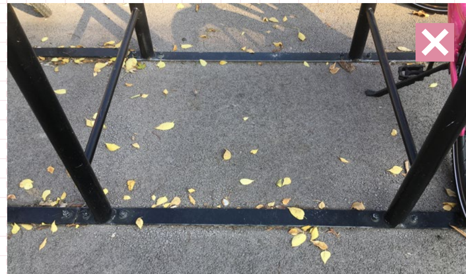
23 Esteticky menej vhodné povrchové kotvenie cyklostojanov pomocou prepojenia jednotlivých stojanov oceľovou pásovinou. Tento typ je nevhodné umiestňovať do historického a kompaktného mesta.
