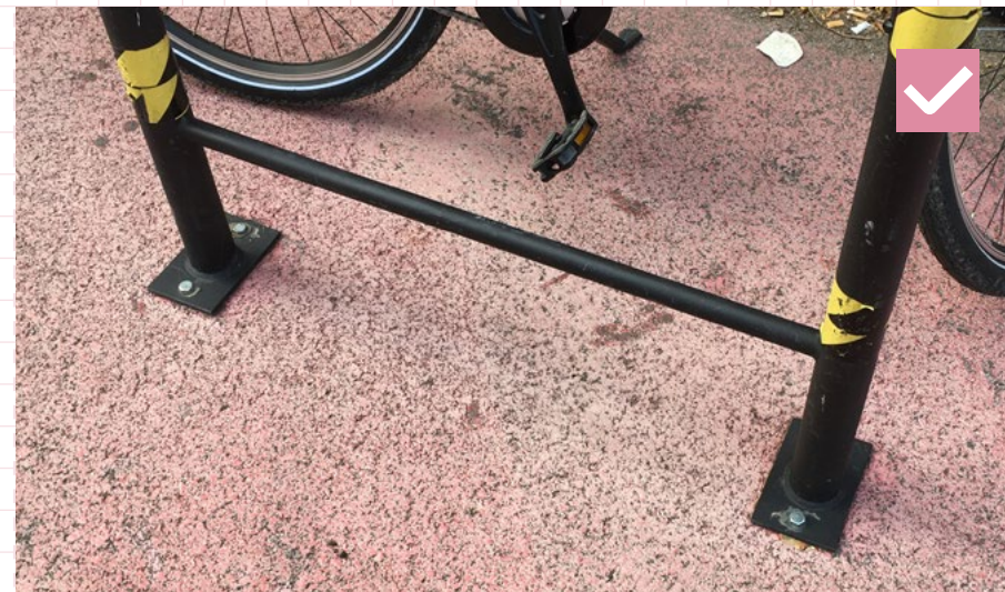
22 Vhodný príklad povrchovo kotveného stojana v kombinácii s vystužením na liatom povrchu. Tento typ kotvenia však nie je vhodný do historického a kompaktného mesta.
