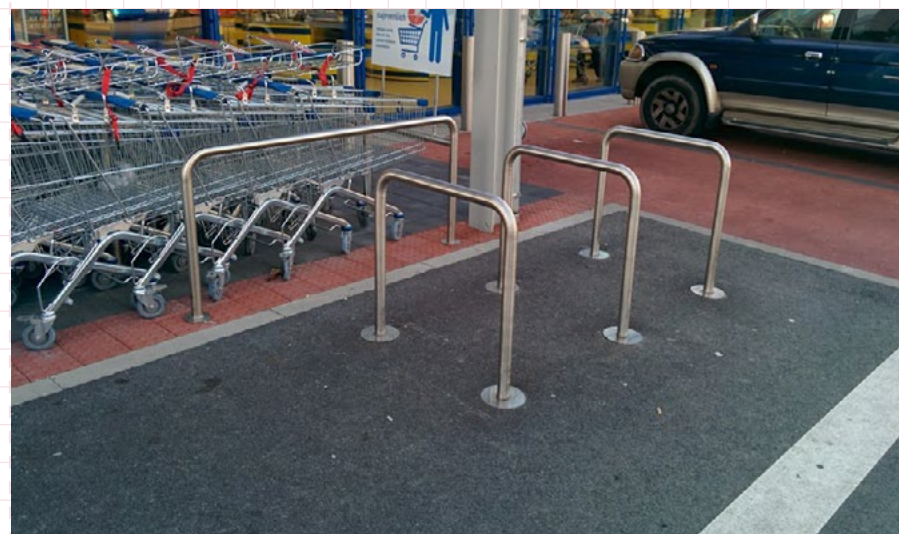
14 Príklad vhodného typu robustnejšieho stojana z pozinkovanej ocele, ktorý vhodne zapadá do kontextu okolia. Bratislava, Pekná cesta
